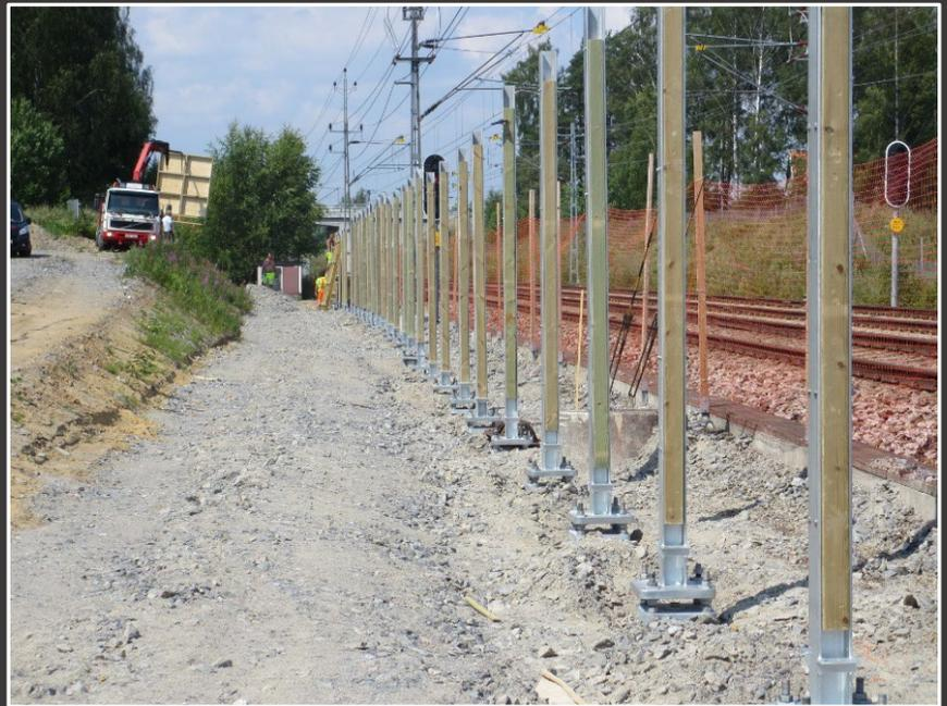
Bei schwereren Gründungen wird der Pfahlkopf in die Gründung eingeführt, während diese auf dem Boden liegt. Anschließend wird die Plattensicherung in einem Flügel befestigt und die Gründung an ihren Platz gehoben.
