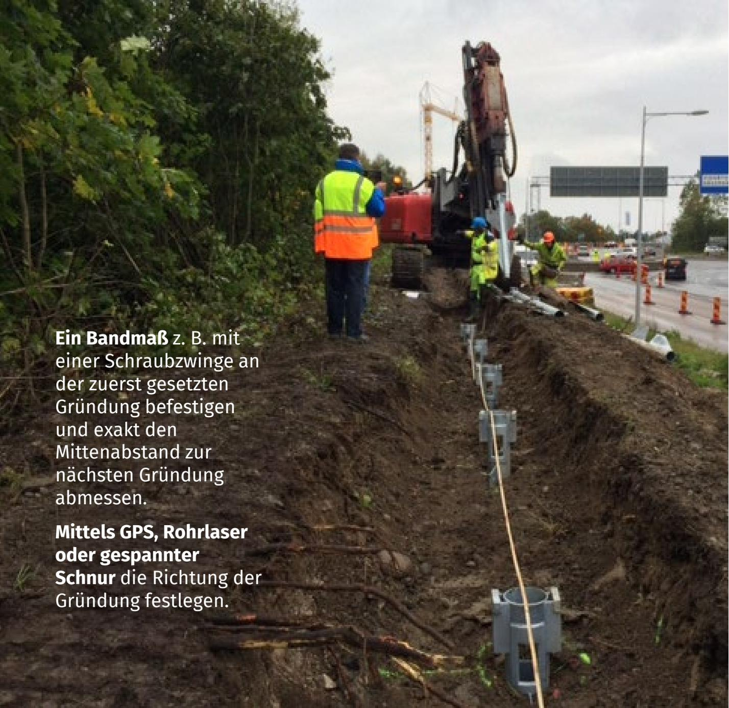
**Ein Bandmaß** z. B. mit einer Schraubzwinde an der zuerst gesetzten Gründung befestigen und exakt den Mittenabstand zur nächsten Gründung abmessen.
